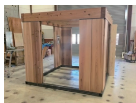
写真3 富山県産材を用いた耐震シェルター
